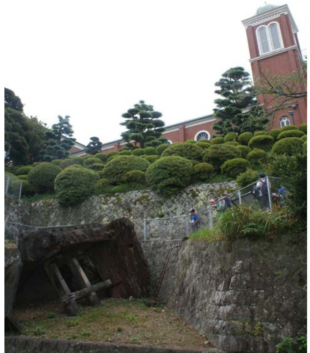
吹き飛ばされた大浦天主堂の鐘楼 (左下)
